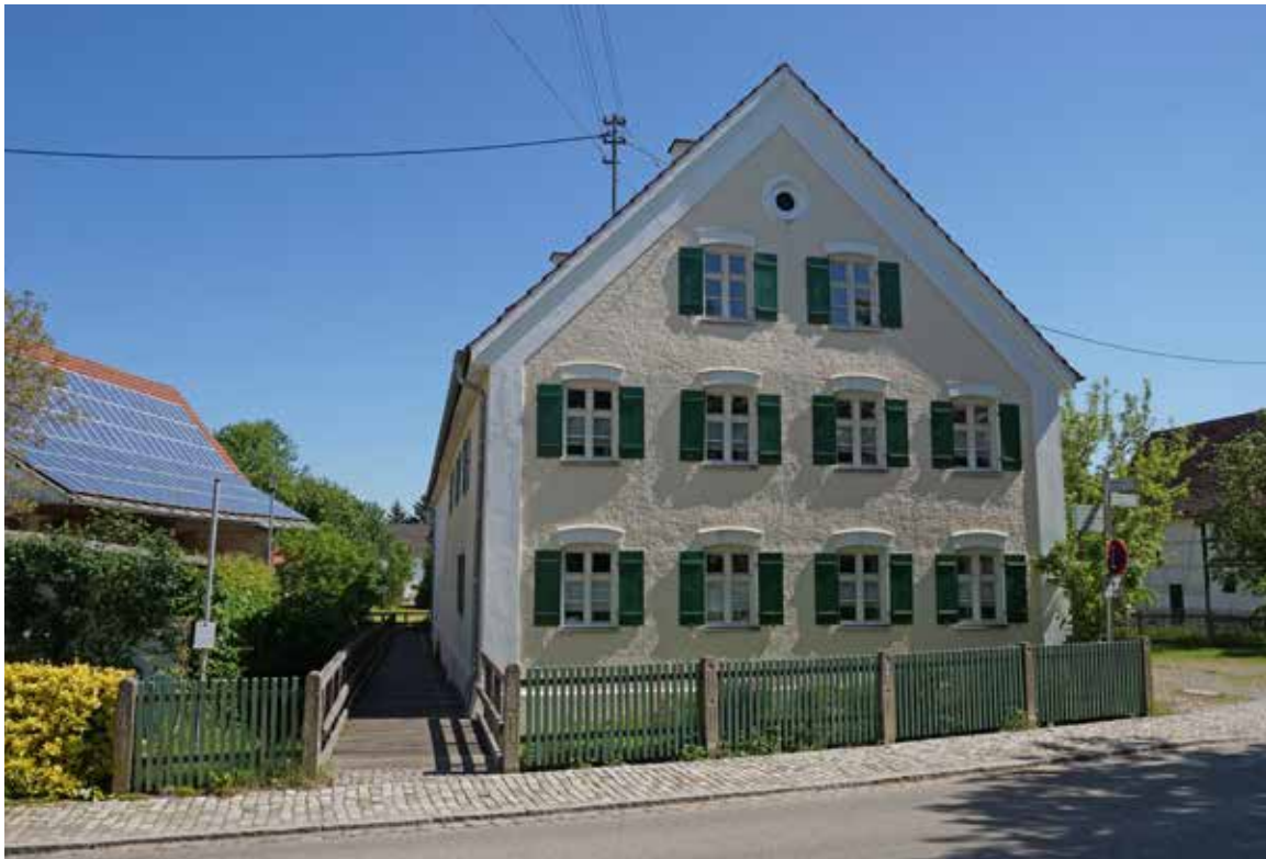
◆ Der Ein- oder Ausstieg des neuen Fußwegs erfolgt über einen Holzsteg neben der Kreisheimatstube.
