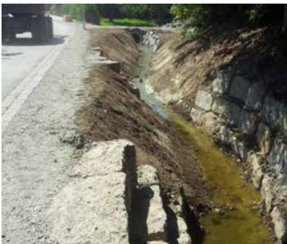
◆ Auf einer Länge von 55 Metern erhielt der Dorfbach einen geschwungenen Verlauf und wurde am Ufer mit Natursteinen befestigt.
