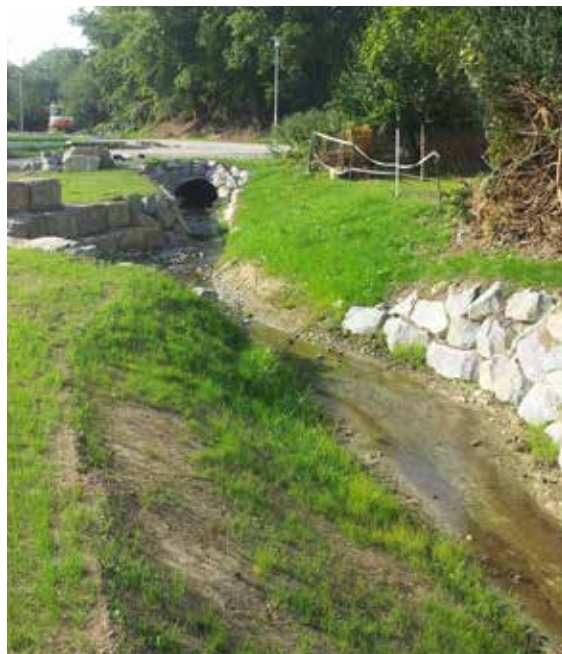
◆ Der Dorfbach wurde auch im Bereich der Freizeitanlage renaturiert und ist Teil des Wassererlebniskonzeptes im Ortsbereich.
