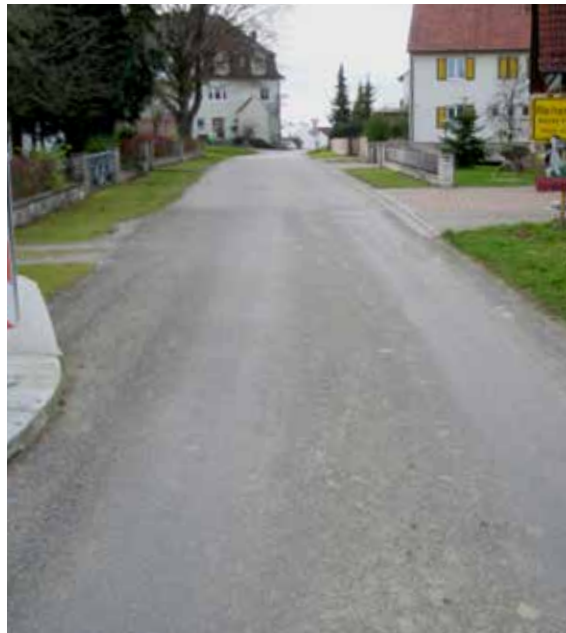
◆ So sah die Straße vor der Baumaßnahme aus.
